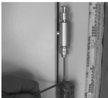
2. Bandbolzen von unten mit einem 4 mm Inbus-schlüssel herausdrücken. Beim unteren Band beginnen. Türflügel aushängen und abstellen.
