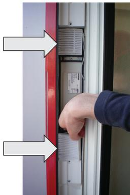
Filtermatten darüber setzen und Abdeckung wieder montieren.
