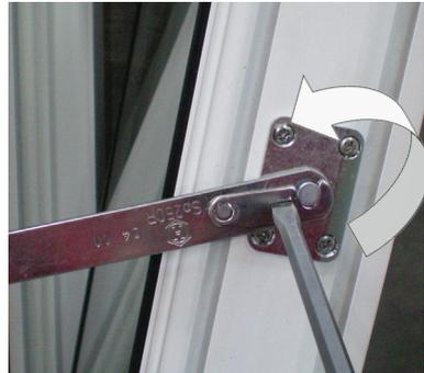
Verriegelung der Putzschere mit einem Flachsraubendreher öffnen und Putzschere aushängen.
