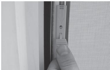
1. Den Spannrahmen an den Haltegriffen durch die Rahmenlichte auf die Außenseite fädeln. Die unteren Einhängewinkel zuerst zwischen Fensterrahmen und Dichtung einhängen.
