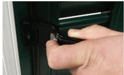
Beim **Schließen** des Ladens wird der Ladenhalter gedrückt und der Laden hereingedreht. Danach den Verschlusshebel drehen bis der Drehstangenverschluss selbsttätig einrastet.
