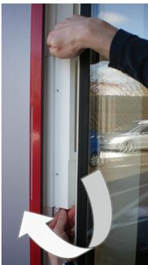
Den Flügel etwas zuziehen und die Abdeckung beim Abnehmen nach außen kippen.
