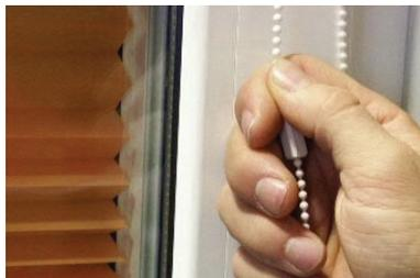
2. Anschließend durch möglichst gerades Nachuntenziehen der Kugelkette die Jalousie in gewünschte Position bringen und in der Kugelkettenhalterung wieder fixieren.
