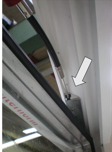
Anheben und Absenken des Flügels mit Inbusschlüssel SW4.
