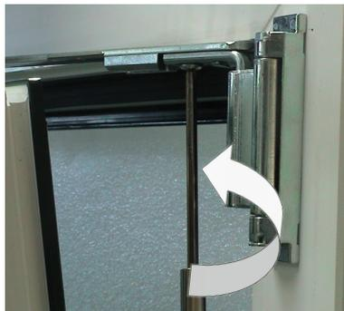
**Anpressdruckverstellung an der Schere:**
