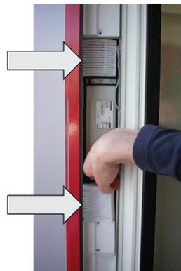
Verschmutzte Filter entfernen und neue Filter einsetzen.
